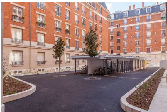
Résidence Terrage - Paris 10 ème 219 logements
